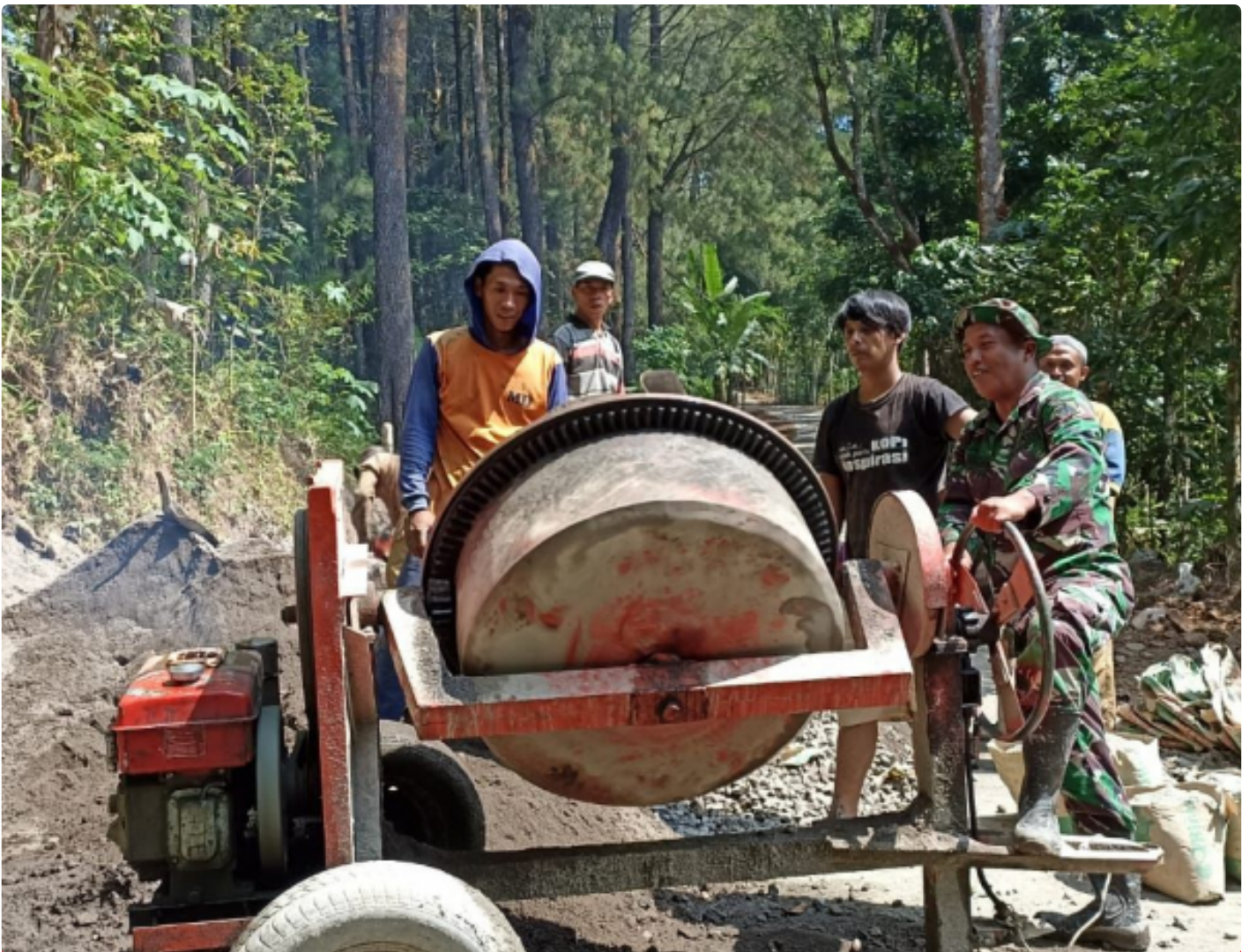
Satgas TMMD kebut pengecoran jalan
